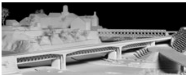
Ingenieure: Frick + Gatteringer, Vaduz; Landschaftsarchitekten: Andreas Geser Landschaftsarchitekten, Zürich; Architekten: Innauer-Matt Architekten ZT, Bezau, Vorarlberg
